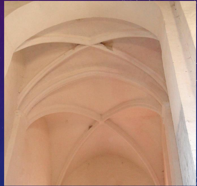
La croisée des voûtes du chœur : maçonné sur des couples en bois puis garnie de moellons en enduits
