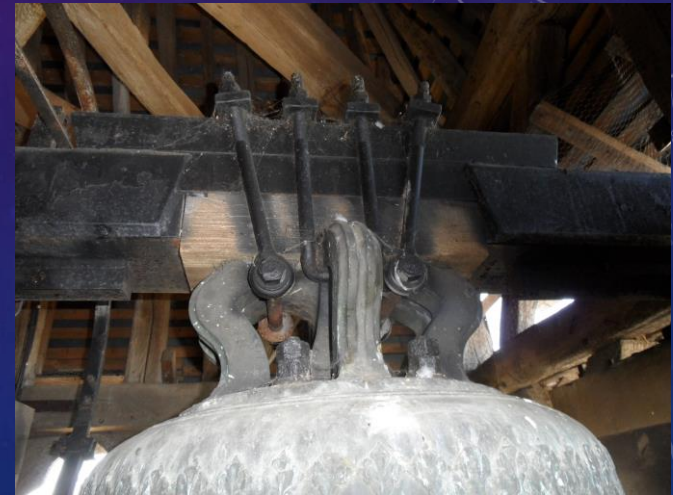
Le mouton appelé aussi joug, généralement en bois, soutient la cloche et permet la mise en volée
