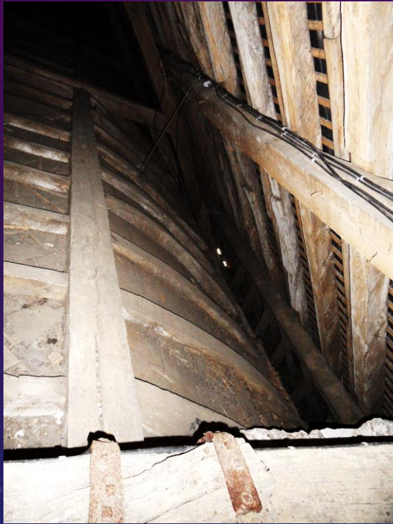
Sous le toit de la Collégiale, la charpente aux arrondis tels les couples d'un navire
