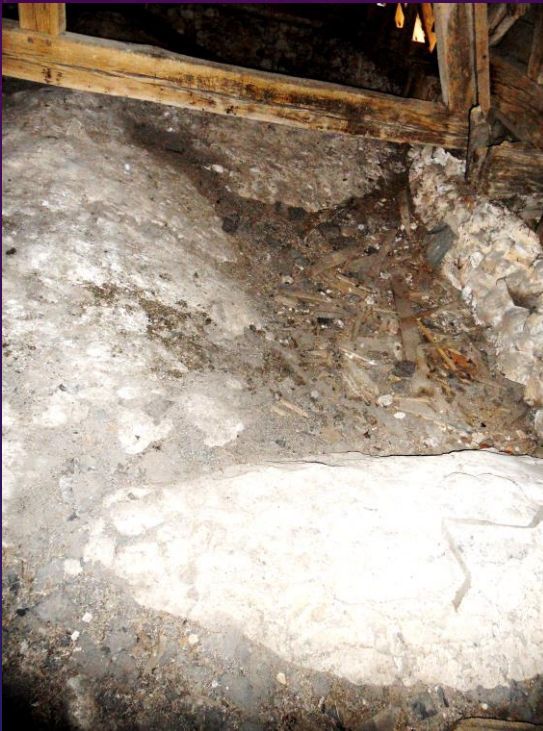
Le dessus des voûtes : les moellons
